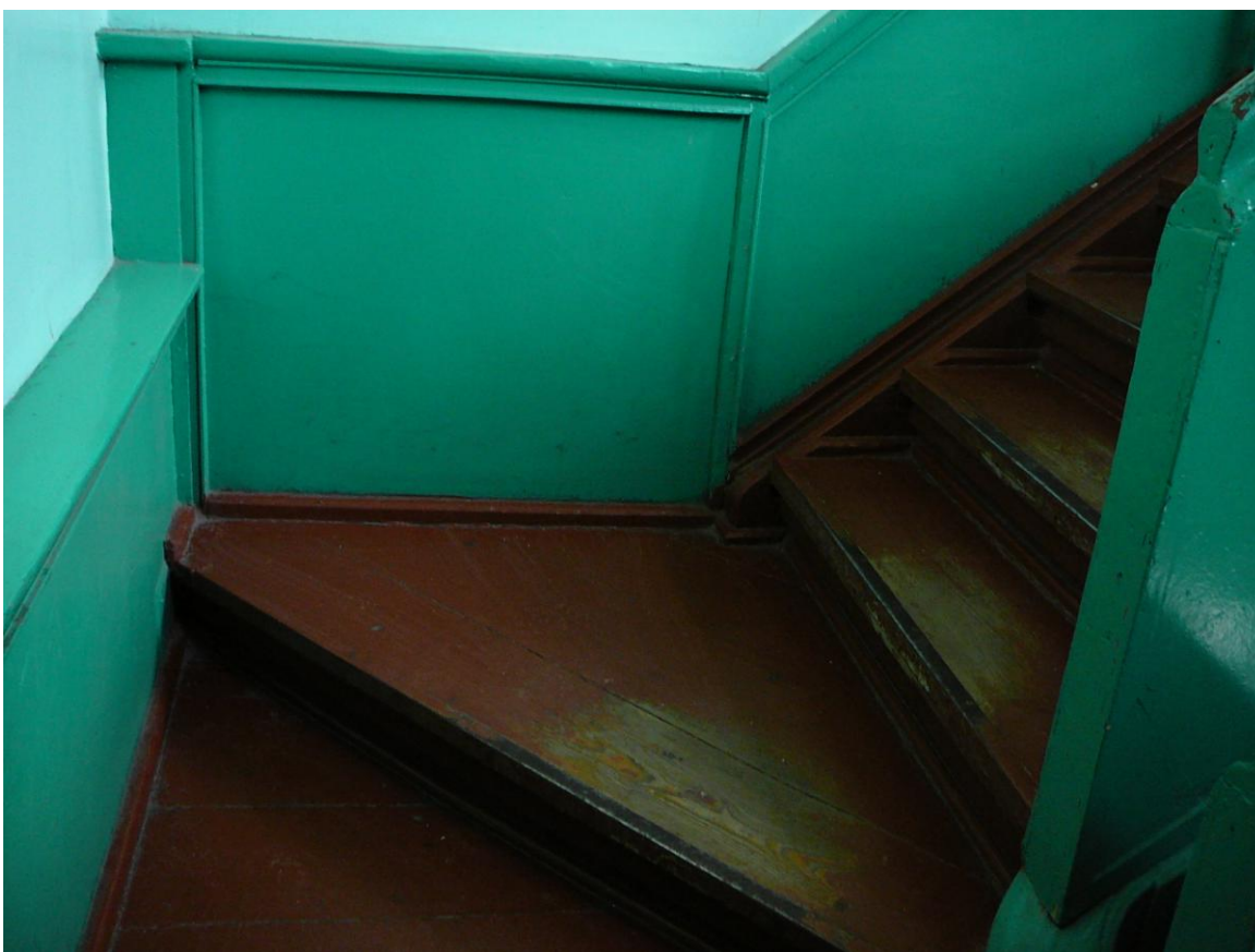
Klatka schodowa w konstrukcji drewnianej
