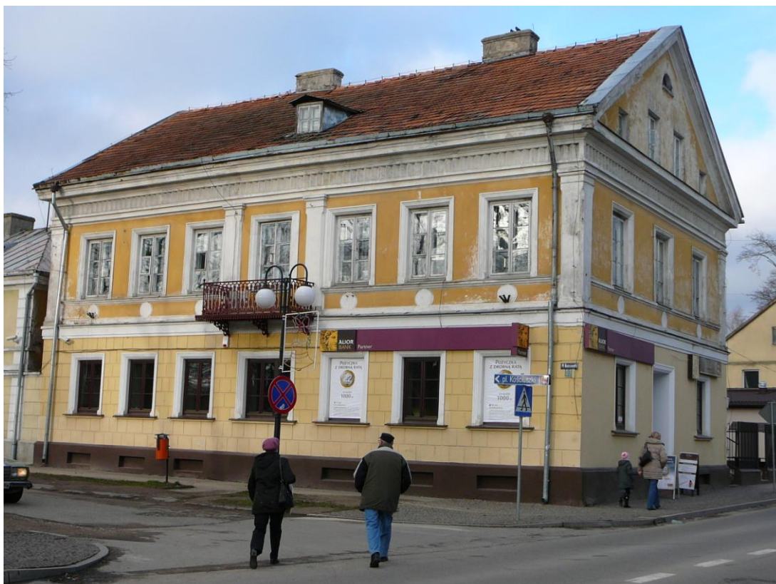
Widok budynku istniejącego – część główna
