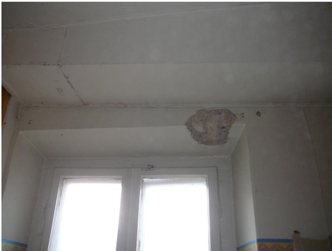
Nadproże okienne, z cegły – widok od strony pomieszczenia
