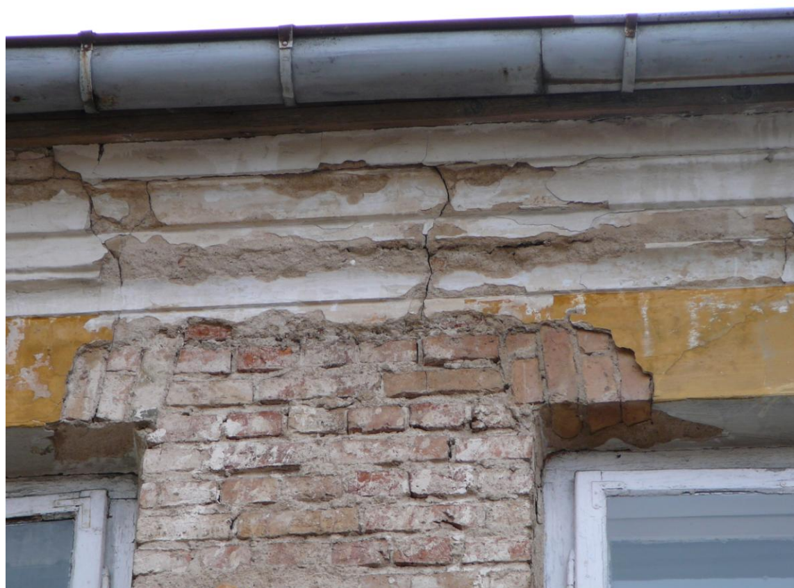
Nadproża okienne i gzyms z cegły – widok od strony elewacji
