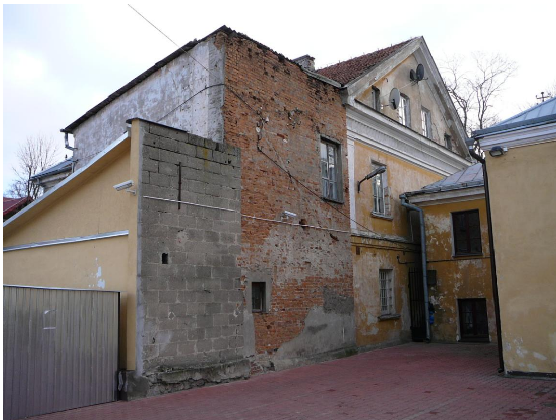
Widok budynku istniejącego z dobudówkami od strony zaplecza
