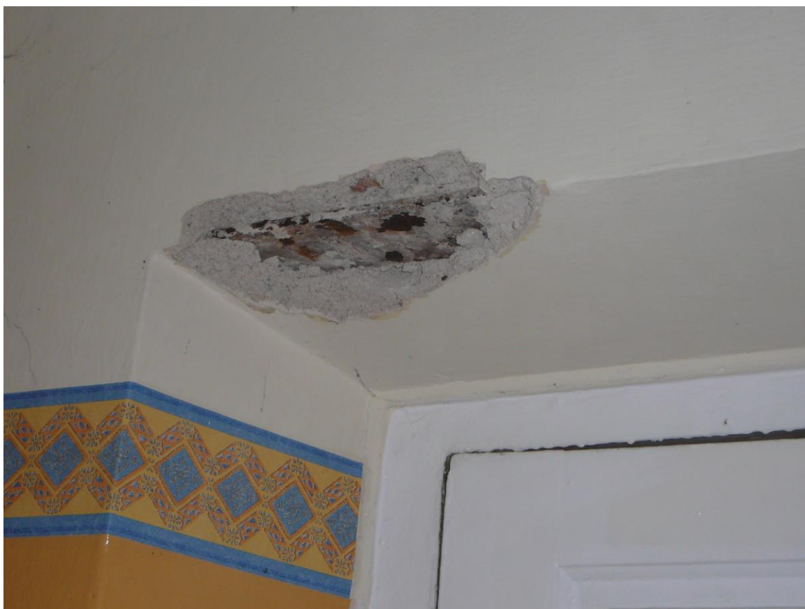
Nadproże w ścianie wewnętrznej – widoczna stopka dolna dwuteownika
