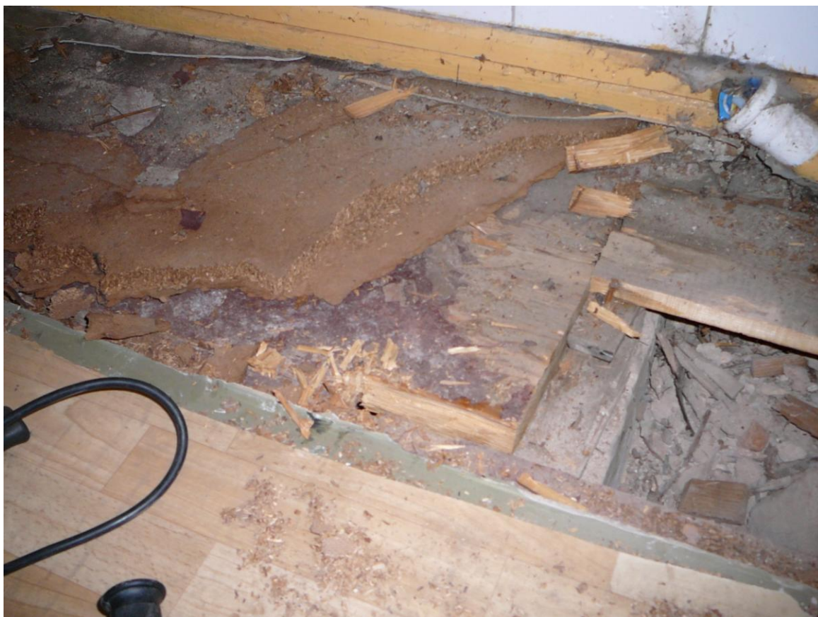
Odkrywka międzypiętrowego stropu ze ślepym pułapem
