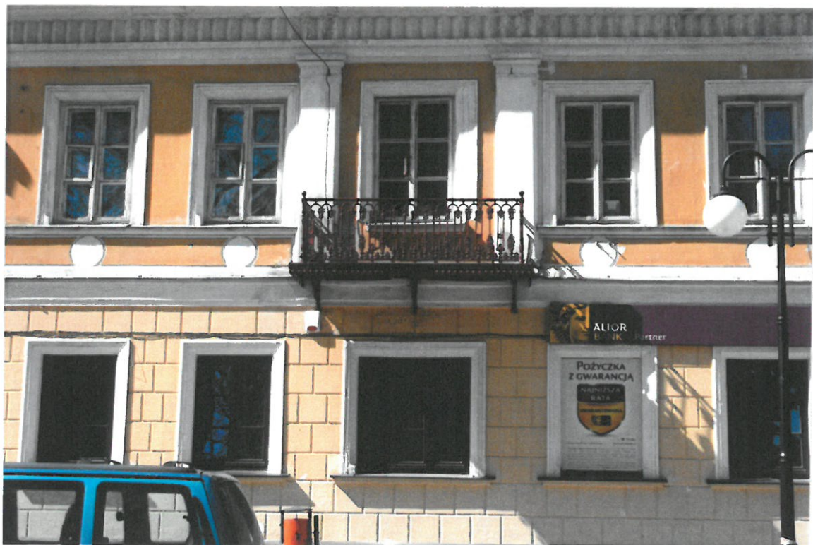
ZDJ.2 SOKÓŁKA. KAMIENICA PRZY UL. PIŁSUDSKIEGO 1. ELEWACJA POŁUDNIOWA OŚ ŚRODKOWA ELEWACJI
