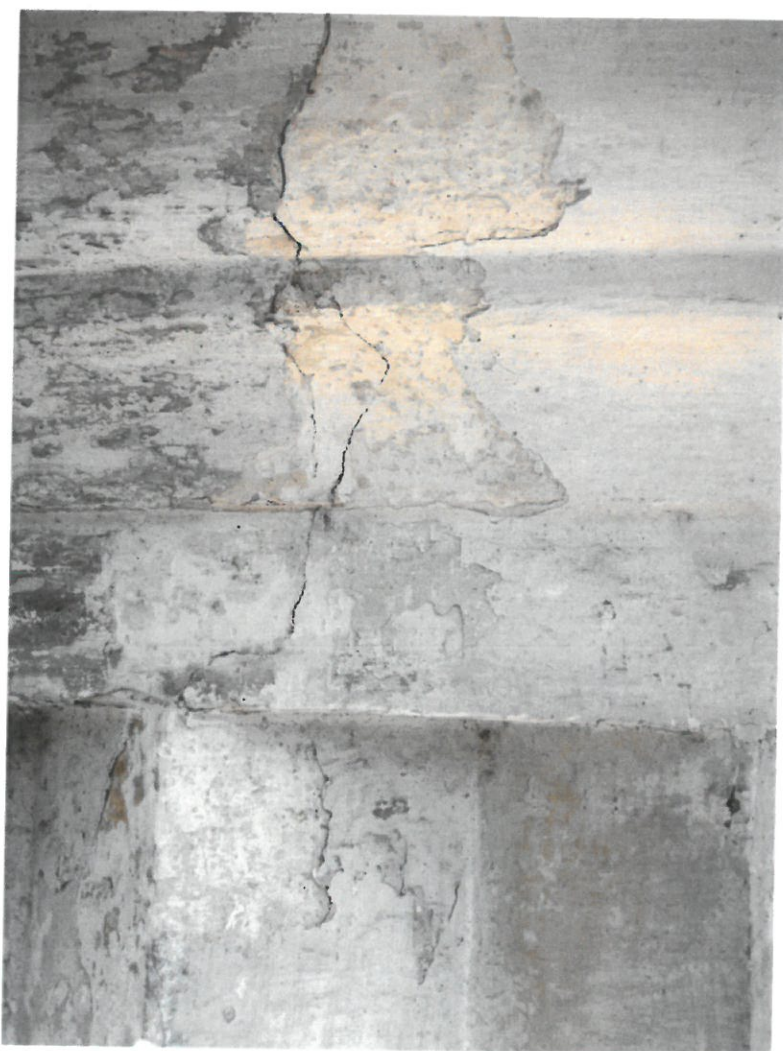
ZDJ. 5 I 6 SOKÓŁKA. KAMIENICA PRZY UL. PIŁSUDSKIEGO 1. ELEWACJA POŁUDNIOWA. ODKRYWKI W OBRĘBIE GZYMSU WIENIĄCEGO I FRYZU – WIDOCZNE ŚLADY NAJSTARSZEJ, BIAŁEJ WARSTWY
