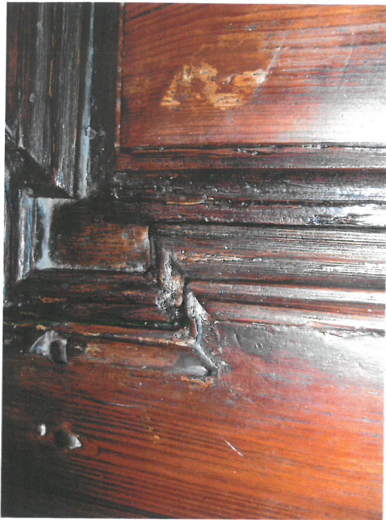
ZDJ. 16 RESZTKI FARBY ZACHOWANE NA KRAWĘDZI DRZWI
