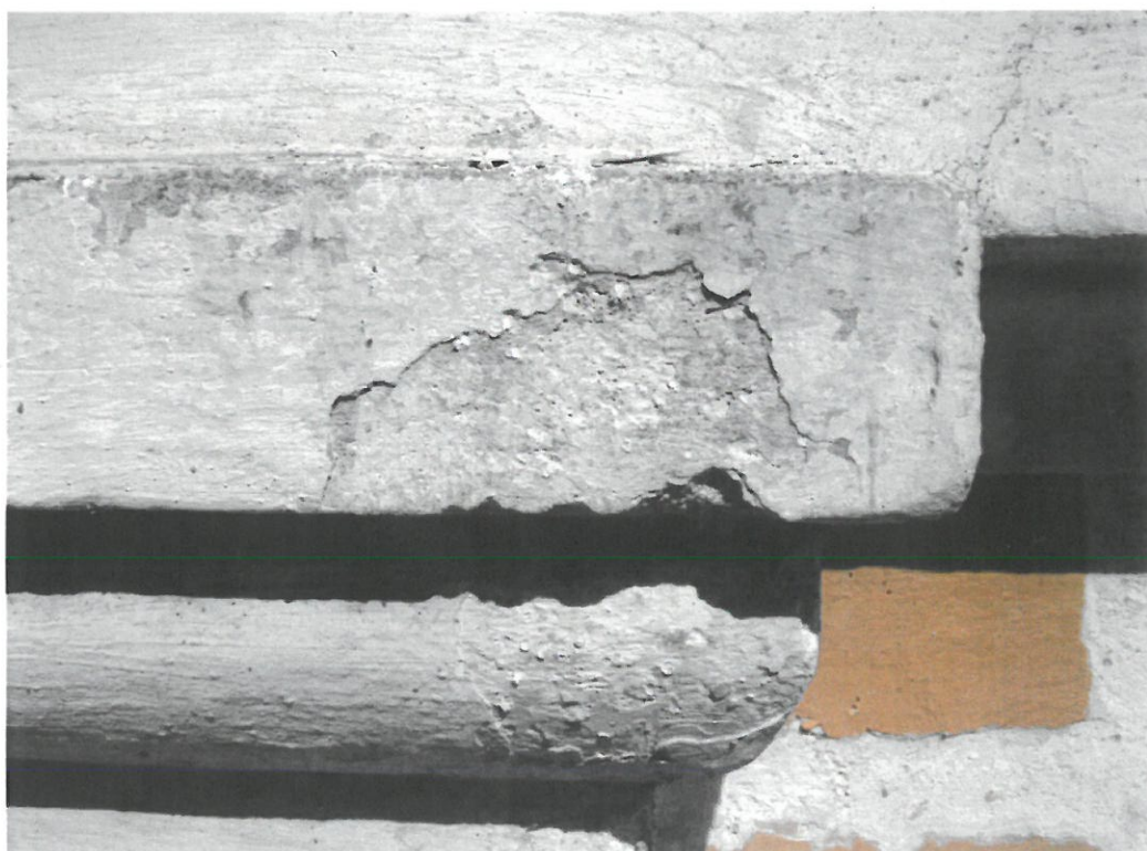
ZDJ. 71 8 SOKÓŁKA. KAMIENICA PRZY UL. PIŁSUDSKIEGO 1. ELEWACJA POŁUDNIOWA. ODKRYWKI W OBRĘBIE KAPITELA – WIDOCZNE ŚLADY NAJSTARSZEJ, BIAŁEJ WARSTWY
