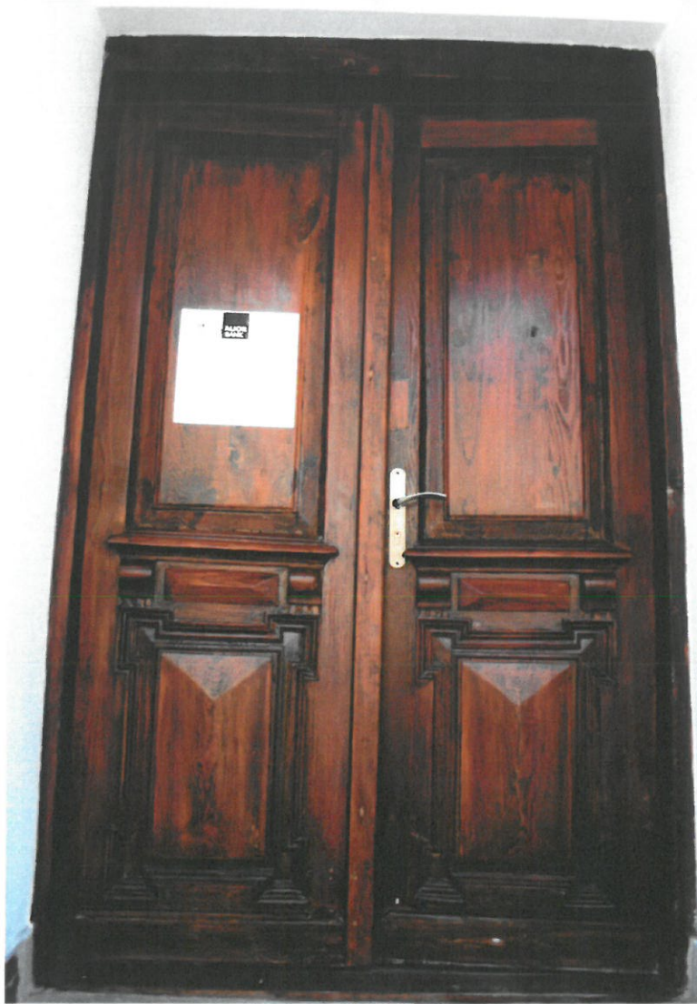
ZDJ. 13, SOKÓŁKA. KAMIENICA PRZY UL. PIŁSUDSKIEGO 1 DRZWI ZEWNĘTRZNE ELEWACJI WSCHODNIEJ – AWERS
