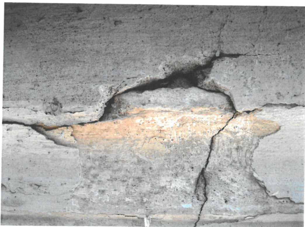
ZDJ. 3 I 4 SOKÓŁKA. KAMIENICA PRZY UL. PIŁSUDSKIEGO 1. ELEWACJA POŁUDNIOWA. ODKRYWKI W OBRĘBIE GZYMSU WIEŃCZĄCEGO – WIDOCZNE ŚLADY NAJSTARSZEJ, BIAŁEJ WARSTWY
