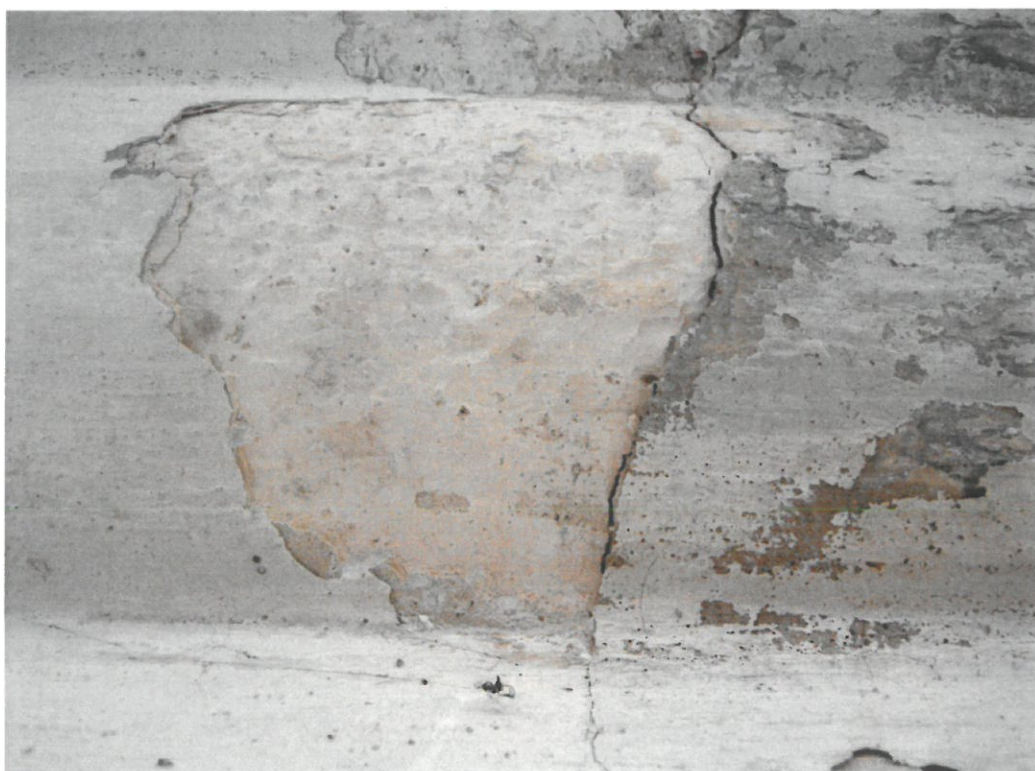
ZDJ. 5 I 6 SOKÓŁKA. KAMIENICA PRZY UL. PIŁSUDSKIEGO 1. ELEWACJA POŁUDNIOWA. ODKRYWKI W OBRĘBIE GZYMSU WIENIĄCEGO I FRYZU – WIDOCZNE ŚLADY NAJSTARSZEJ, BIAŁEJ WARSTWY
