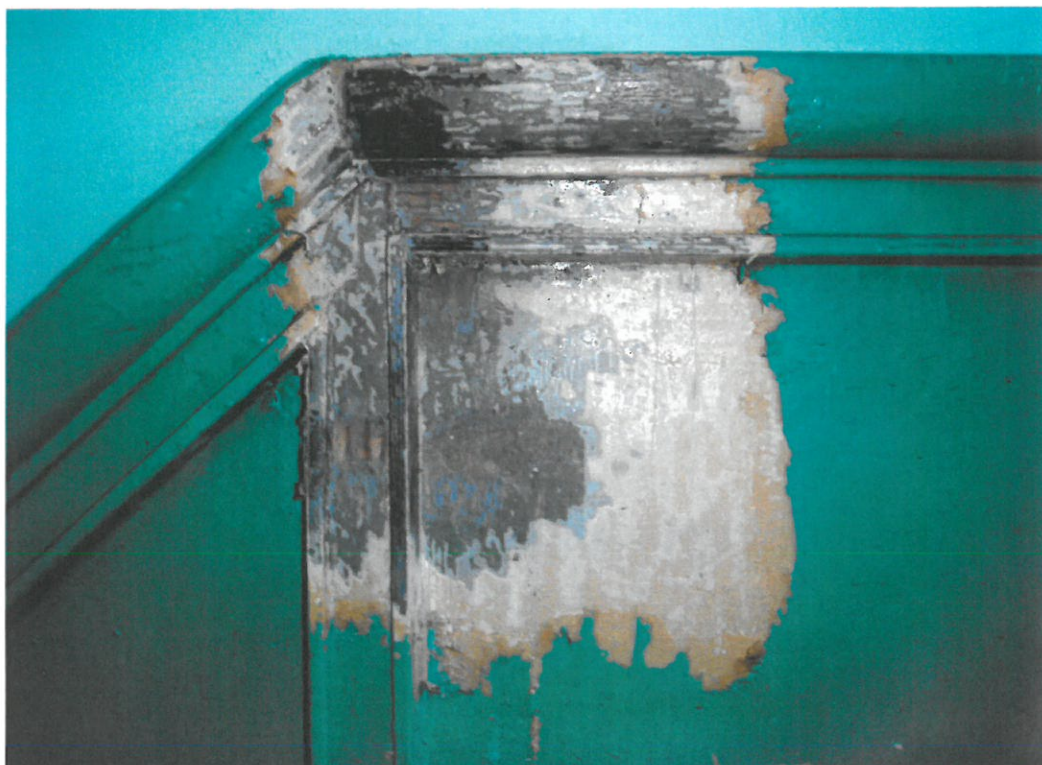
ZDJ. 25, SOKÓŁKA.KAMIENICA PRZY UL. PIŁSUDSKIEGO 1 BOAZERIA KLATKI SCHODOWEJ ZDJ. 26 SOKÓŁKA KAMIENICA PRZY UL. PIŁSUDSKIEGO 1, WIDOCZNE ZRÓŻNICOWANIE BARWIENIA ELEMENTÓW BOAZERII
