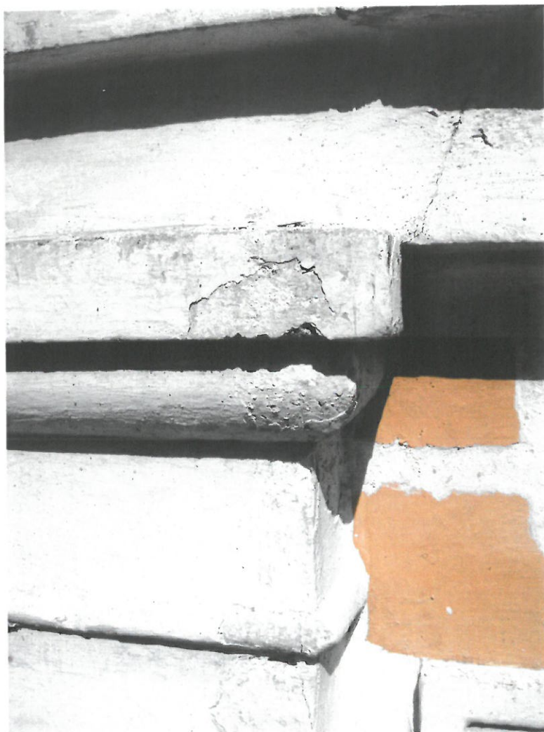
ZDJ. 71 8 SOKÓŁKA. KAMIENICA PRZY UL. PIŁSUDSKIEGO 1. ELEWACJA POŁUDNIOWA. ODKRYWKI W OBRĘBIE KAPITELA – WIDOCZNE ŚLADY NAJSTARSZEJ, BIAŁEJ WARSTWY
