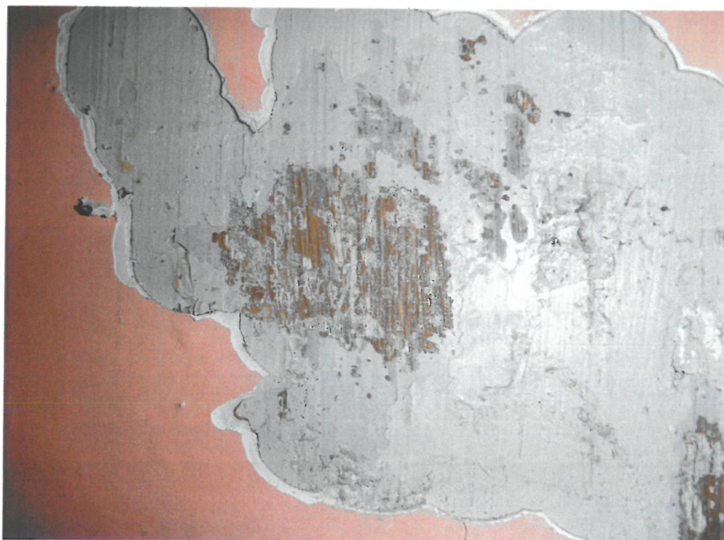
ZDJ. 19, SOKÓŁKA.KAMIENICA PRZY UL. PIŁSUDSKIEGO 1,DRZWI A, REWERS ZDJ. 20 SOKÓŁKA KAMIENICA PRZY UL. PIŁSUDSKIEGO 1, DRZWI A REWERS - MAZERUNEK
