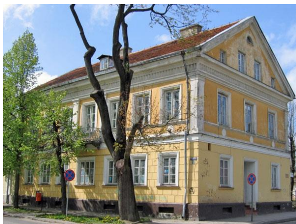
Budynek kamienicy w Sokółce przeznaczony do remontu
