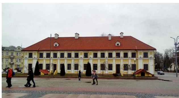
Budynek kamienicy w Grodnie przeznaczony do remontu
