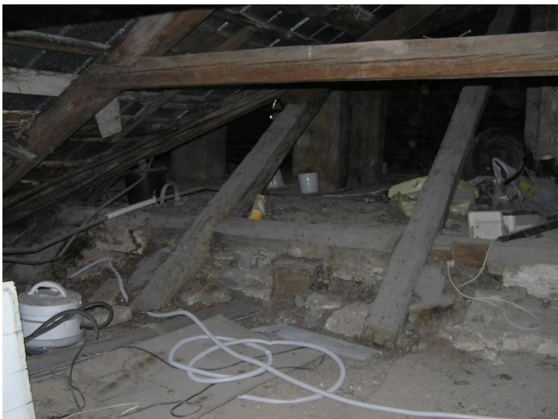
Fot.16. Więźba dachowa. Połączenie kamienicy z oficyną.
