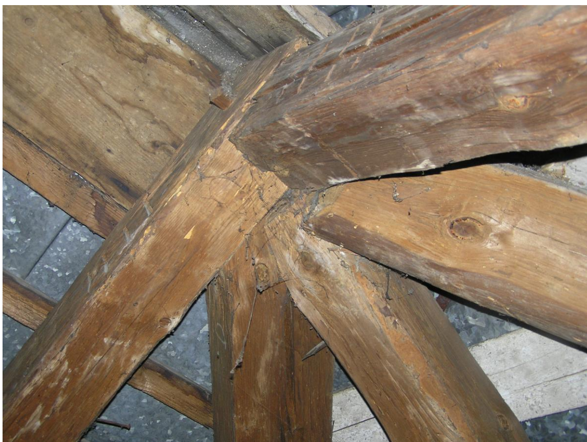
Fot.18. Więźba dachowa. Połączenie w kalenicy krokwi zwykłych i narożnych.
