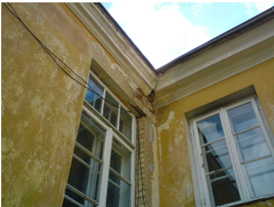
Fot.4. Widok na połączeniu kamienicy z oficyną.
