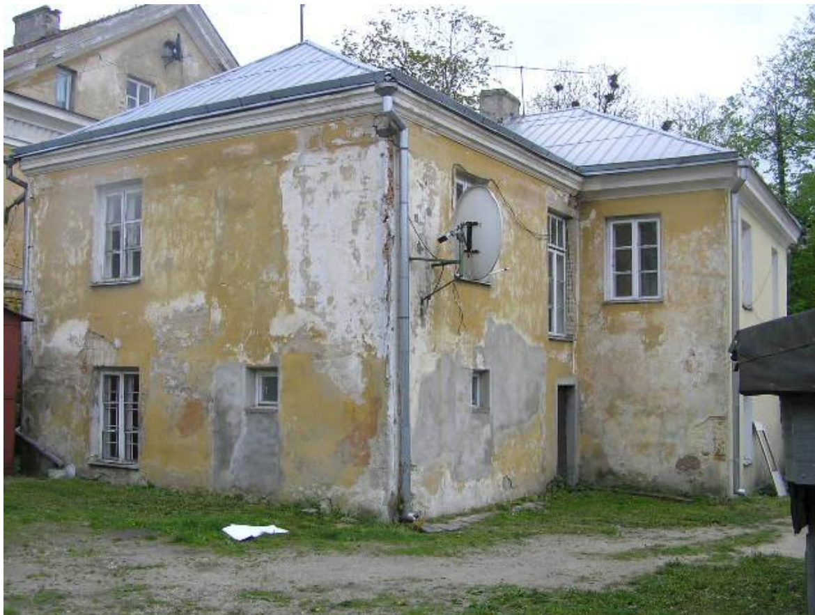
Fot.2. Widok kamienicy od strony zaplecza (oficyna).
