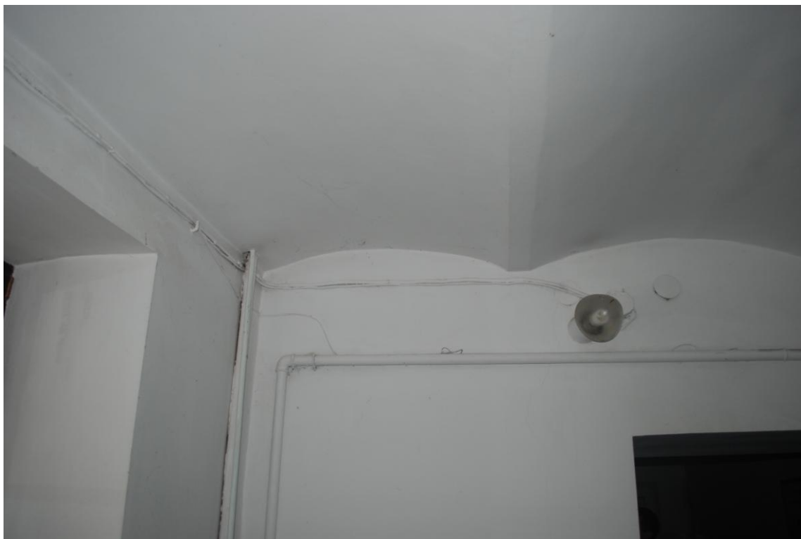
Fot.9. Widok ogólny stropu.
