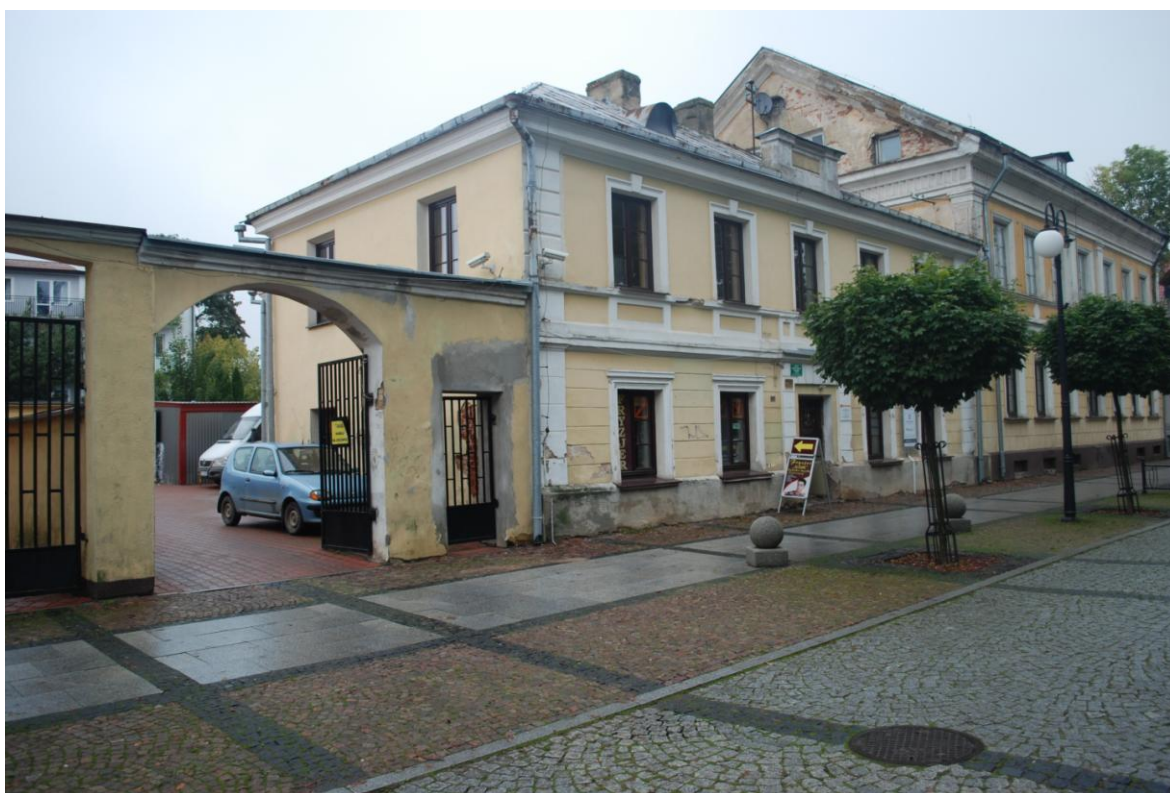
Fot.1. Północna fasada kamienicy od strony Placu Kościuszki.
