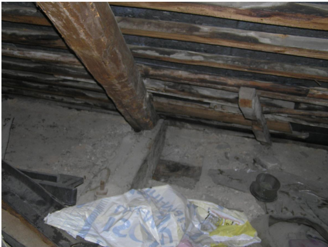
Fot.17. Więźba dachowa. Widok krokwi i ołacenia.
