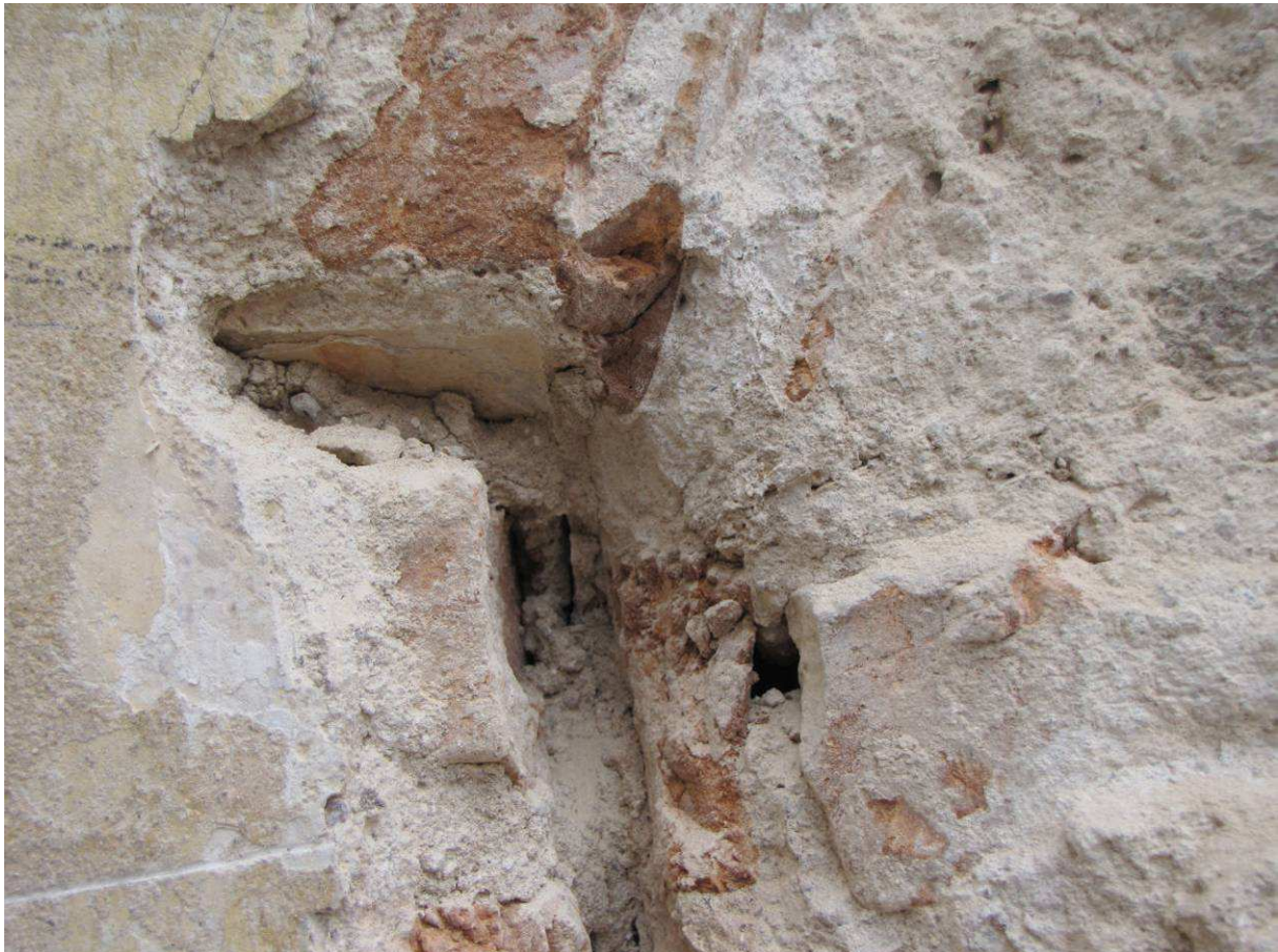
Fragment odkrywki nr 2 ze stanowiska „A” z widocznym, pierwotnym wymalowaniem tynku nadproża.
