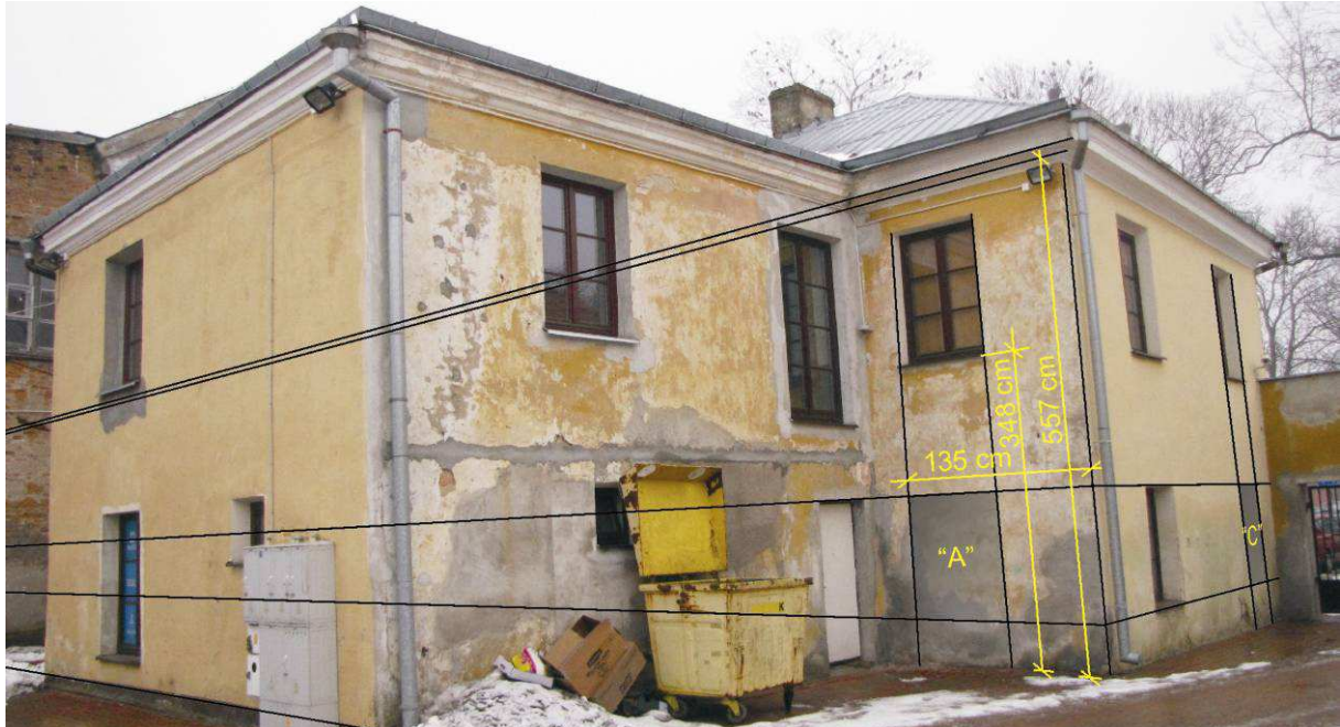
Widok zachodniej części elewacji północnej korpusu głównego z lokalizacją odkrywek stanowiska „A”
