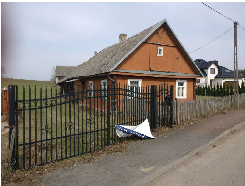
Zagroda nr 16. Chałupa i budynek inwentarski pod jednym dachem, kryta eternitem. Ściany obite płytką. Opuszczona. Fot. M. Andron 2021.
