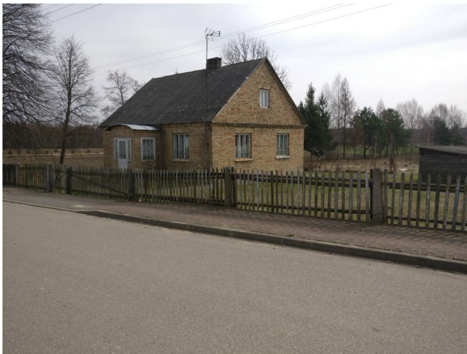
Zagroda nr 3. Dom mieszkalny murowany, nietynkowany, dach nakryty eternitem. Fot. M. Andron 2021.
