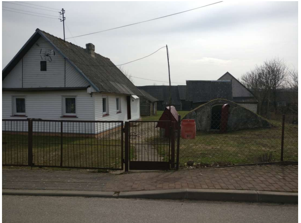
Zagroda nr 7. Dom mieszkalny obity sidingiem, dach nakryty eternitem, wolnostojące budynki gospodarcze nakryte dachami z eternitu. Dach studni nakryty blachą. Ogrodzenie z siatki metalowej. Fot. M. Andron 2021.
