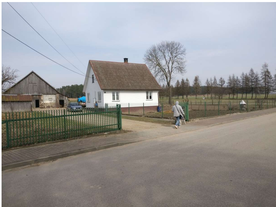
Zagroda nr 1, ściany obłożone sidingiem, dach dwuspadowy, pokryty blachą, okna z PCV, ogrodzenie z siatki metalowej. Od strony północnej dostawiono aneks z pustaków. Fot. M. Andron 2021.
