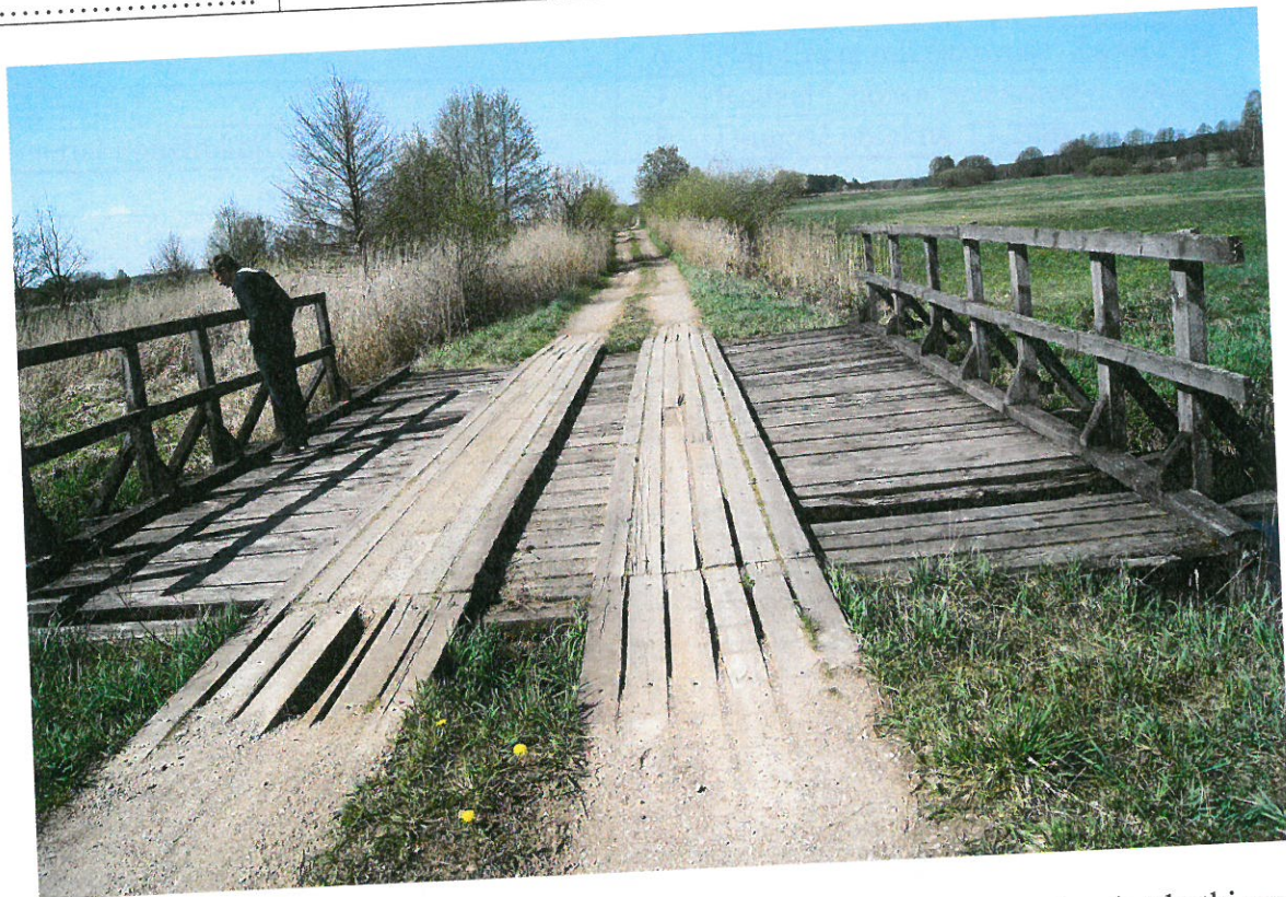
Fot. 8 Na dojazdach do mostu brakuje elementów drewnianych oraz występują ubytki mas ziemnych w nasypach. Występuje wegetacja roślin.
