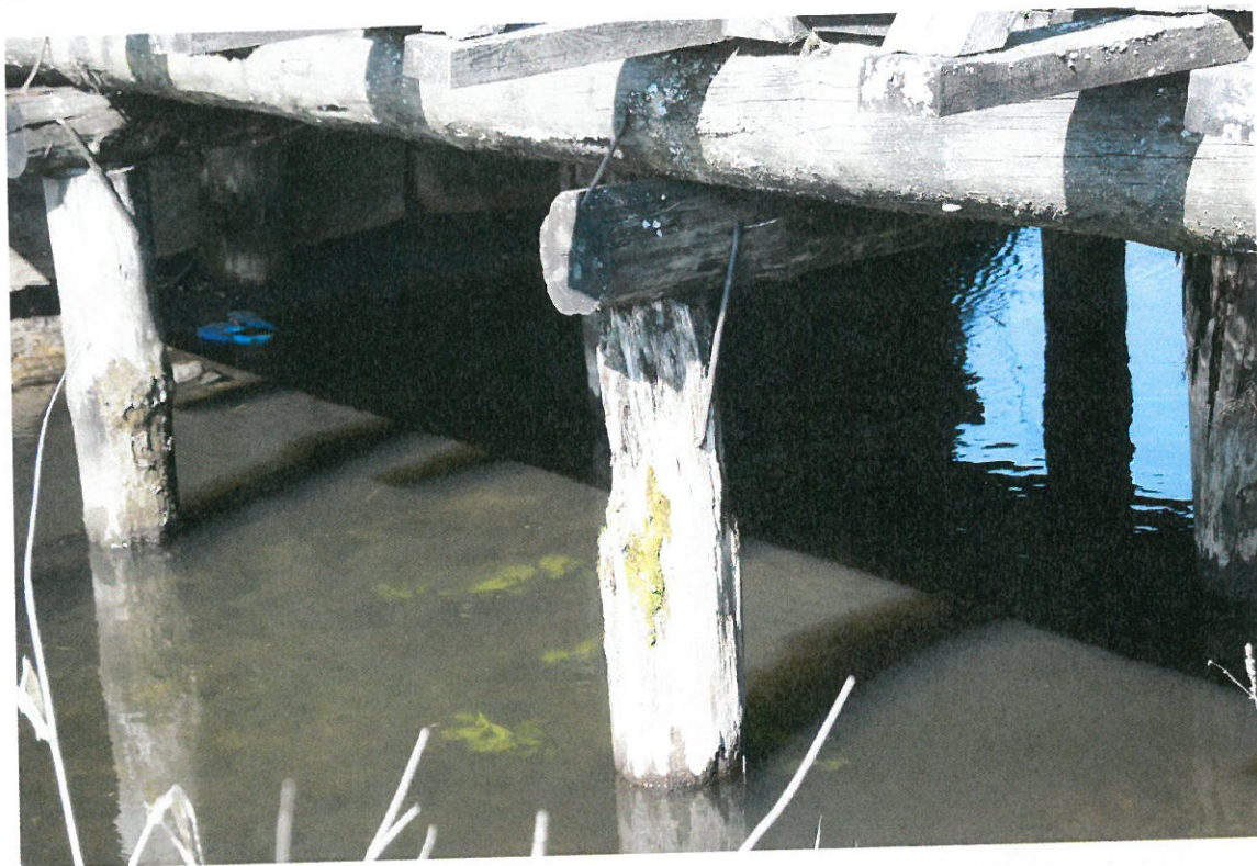
Fot. 6. Korozja biologiczna, gnicie, ubytki, pęknięcia, w słupach drewnianych będącymi podporami pośrednimi oraz w drewnianych dźwigarach – najprawdopodobniej w wyniku starzenia eksploatacyjnego oraz braku izolacji pomostu, która powoduje przeciekanie wody na dźwigary. Widoczne są też zanieczyszczenia, zacieki, wegetacja roślin, mchy na belce podporęczowej.
