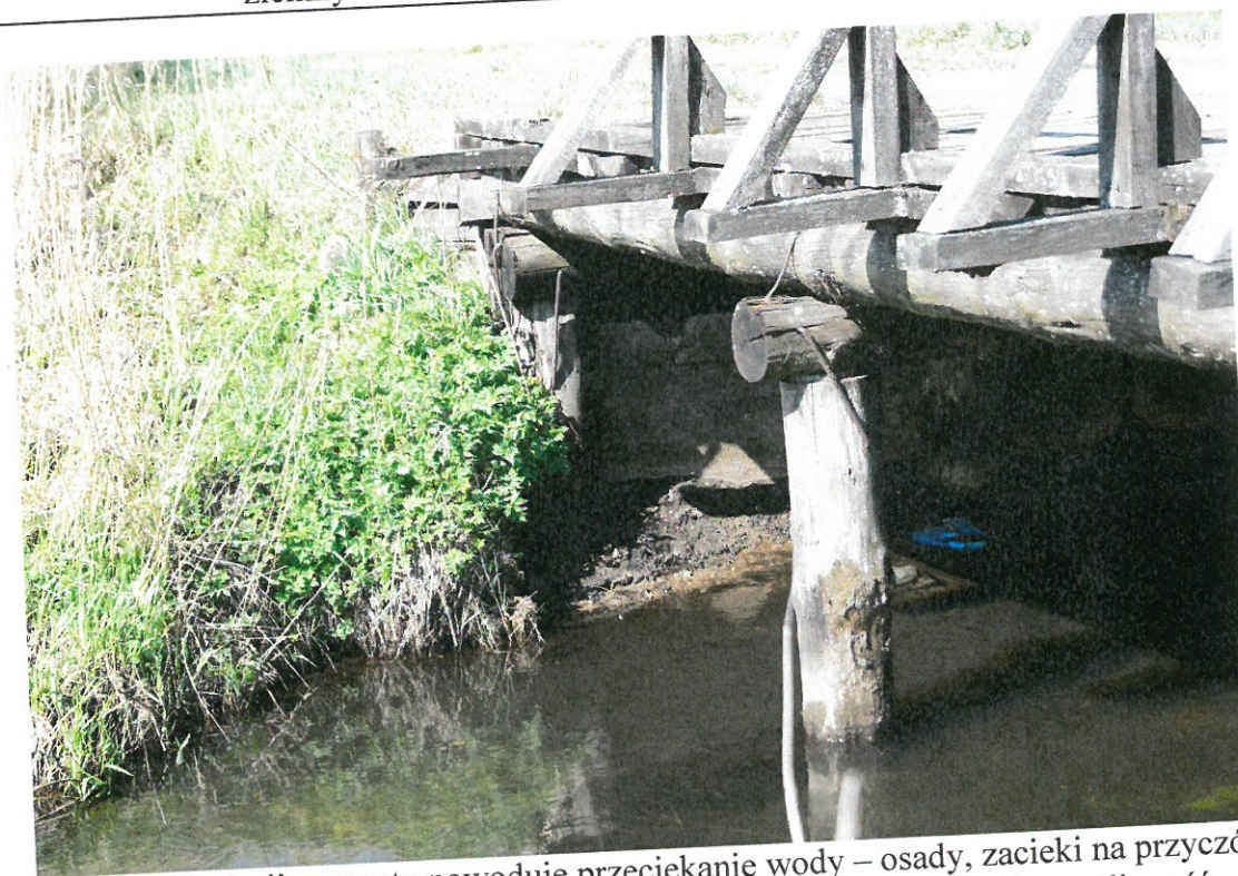
Fot. 8 Na dojazdach do mostu brakuje elementów drewnianych oraz występują ubytki mas ziemnych w nasypach. Występuje wegetacja roślin.
