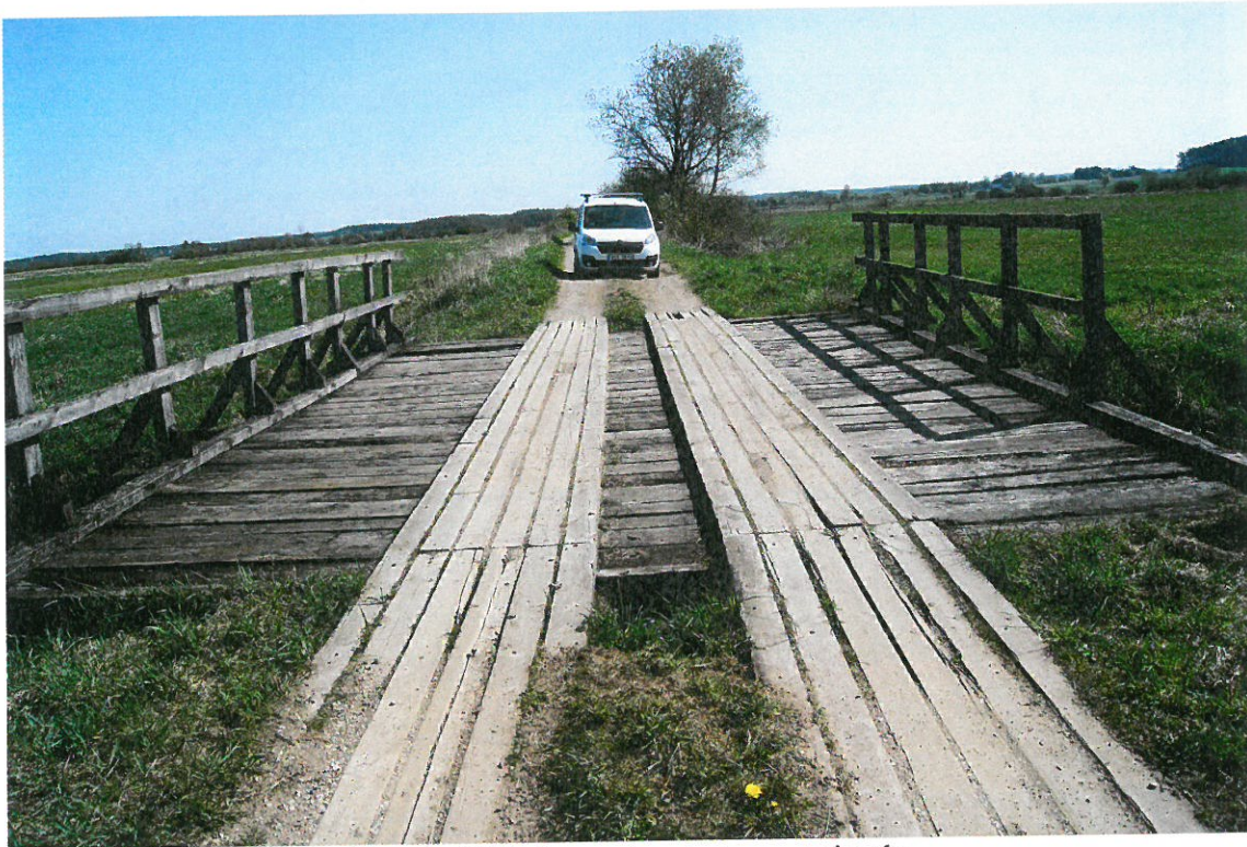
Fot. 1. Widok mostu od strony najazdu
