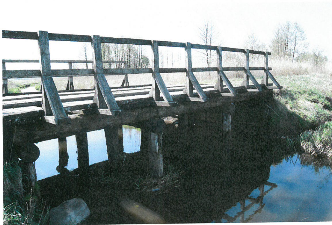
Fot. 2. Widok mostu z boku
