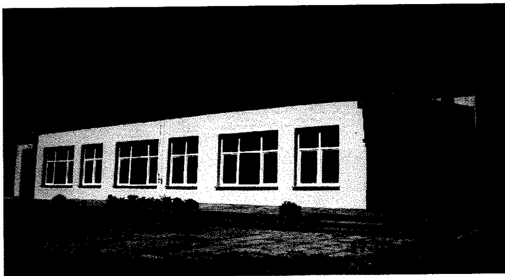
(budynek klubu wiejskiego po remoncie elewacji)
