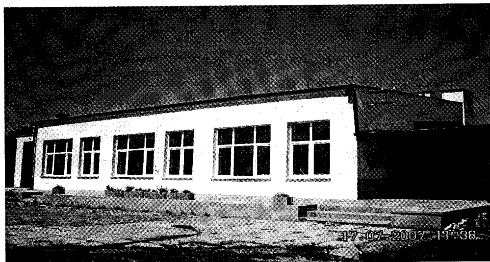
(budynek klubu wiejskiego po remoncie elewacji)
